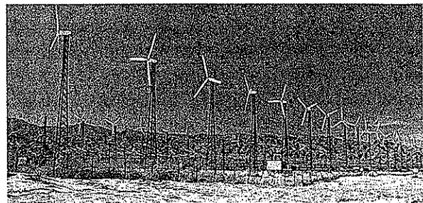
Fig. 6.30 Observemos un parque eólico, en el cual los aerogeneradores producen energía eléctrica a partir de la energía eólica.
